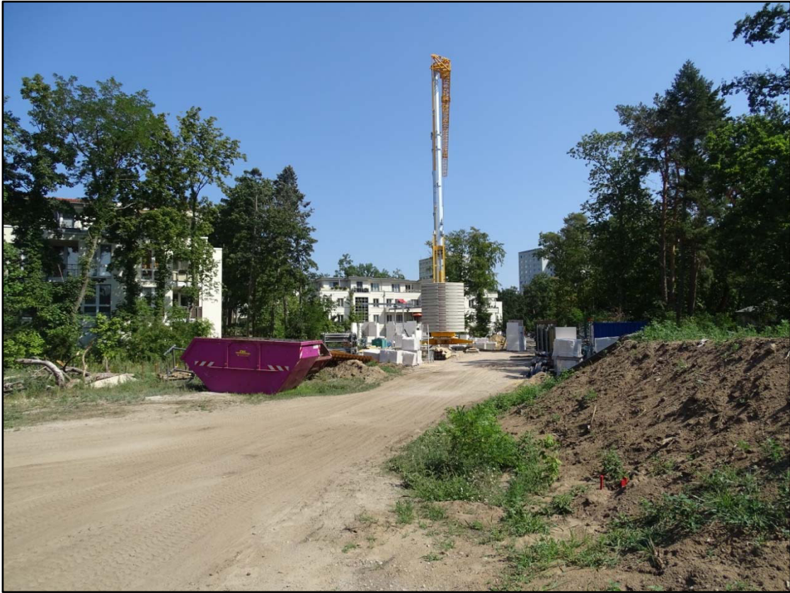
Bild 6 - Bauarbeiten im nördlichen Gebietsabschnitt
