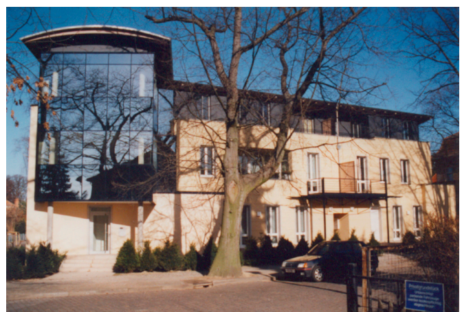
überdimensionierte Glasflächen mit störender Spiegelverglasung
