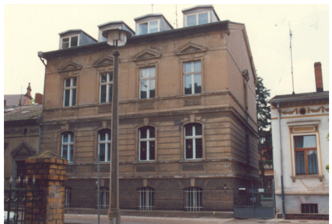
Gauben auf nicht genügend steilen Dachflächen
