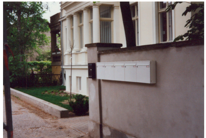
mangelnde Integration von Hausbriefkästen in die straßenseitige Einfriedung
