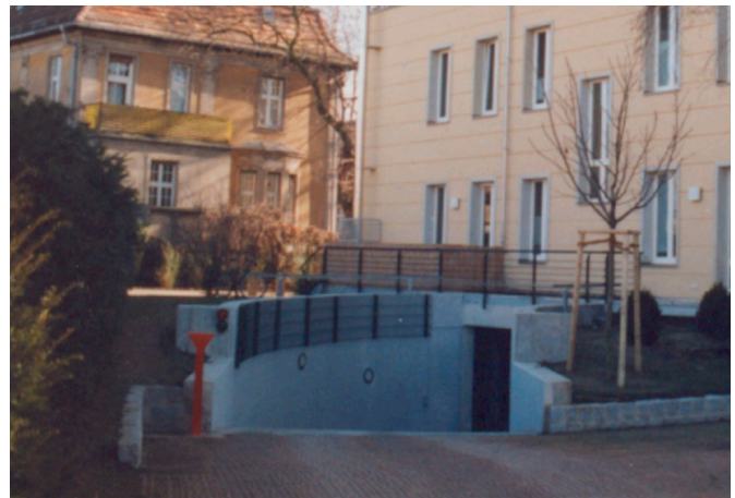
störende Tiefgaragenzufahrt im Vorgartenbereich mit unverkleideten Seitenwänden aus Beton
