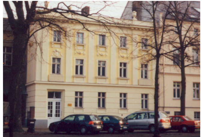
typische Lochfassade mit axialer Fensteranordnung, stehenden Fensterformaten sowie zurückgesetzten, eingefassten und untergliederten Fenstern
