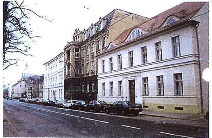
Dachgauben mit Bezug auf Fensterachse der Fassade
