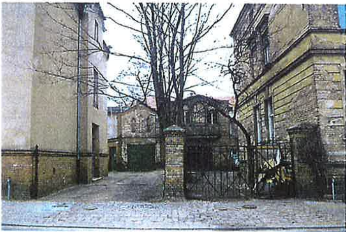
Blick von der Straße auf seitlichen Fassaden und Bauwuch
