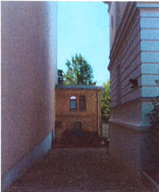
Blick von der Straße auf Remise
