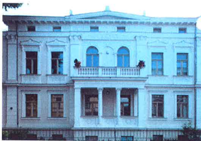
Fassade mit Plastizität
