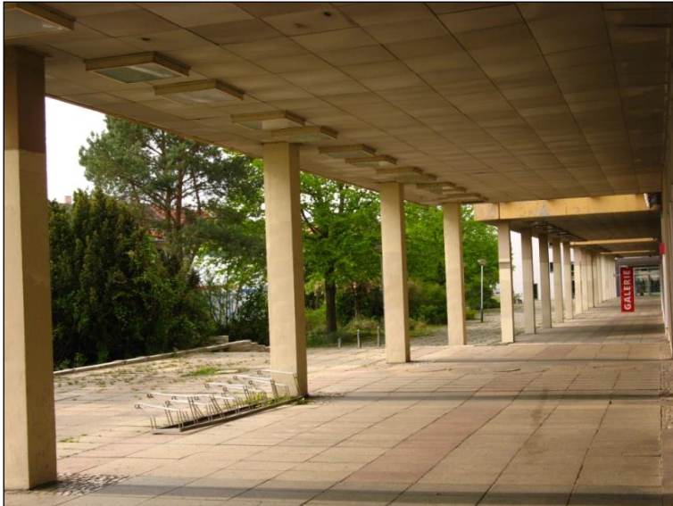
Abb. 1: Kolonnaden an der Westseite des FH-Gebäudes (FRELOT 2016)
