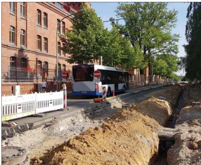
Baustelle Nedlitzer Straße: Busse des öffentlichen Nahverkehrs dürfen die Baustelle entgegen der Fahrtrichtung passieren, eine mobile Ampel regelt den Verkehr. Foto: LHP/jab
