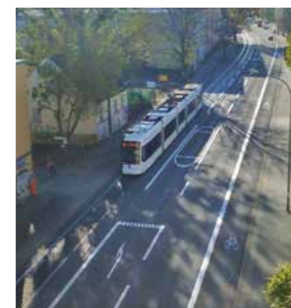
Neue Strecken in der Zeppelinstraße. Künftig wird es zwischen Kastanienallee und Geschwister-Scholl-Straße eine Fahrspur pro Richtung geben. An Straßenbahnhaltestellen werden die Autos auf die mittlere Fahrbahn geführt, um überholen zu können. Ansonsten ist der mittlere Fahrstreifen abwechselnd für Linksabieger reserviert. Die Markierungsarbeiten starten im Juni, der Verkehrsversuch im Juli. Fotos: LHP/Axel Dörrie, Montagen: LHP/Karina Horn
