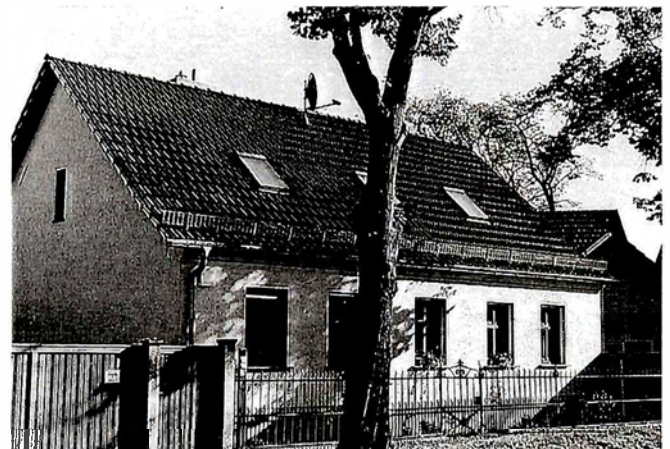
Einfassung des Vorgartens mit schmiedeeisernem Zaun
