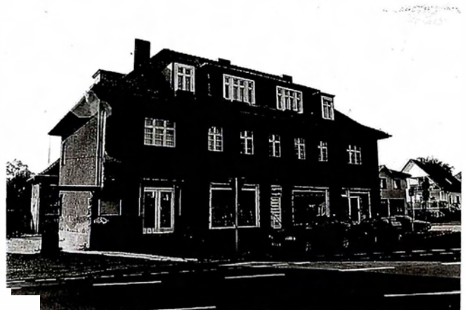
Wohnungsbau der 20-er Jahre im Ortskern von Alt-Drewitz (Sternstraße)
