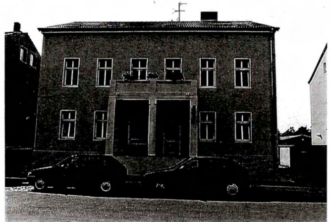
Veränderung der Fassadengestaltung durch äußere Wärmedämmung
