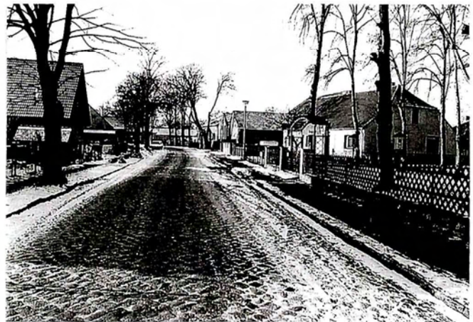
Gepflasterte Dorfstraße nördlich des Dorfgangers
