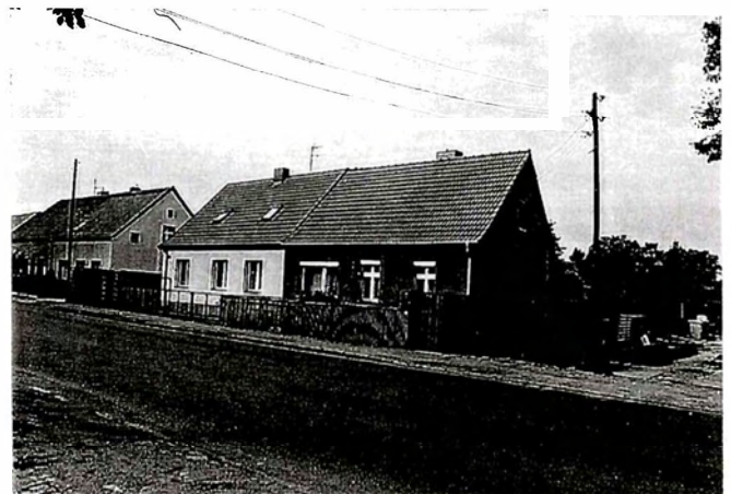
Historische Doppelhausbebauung in der Sternstraße
