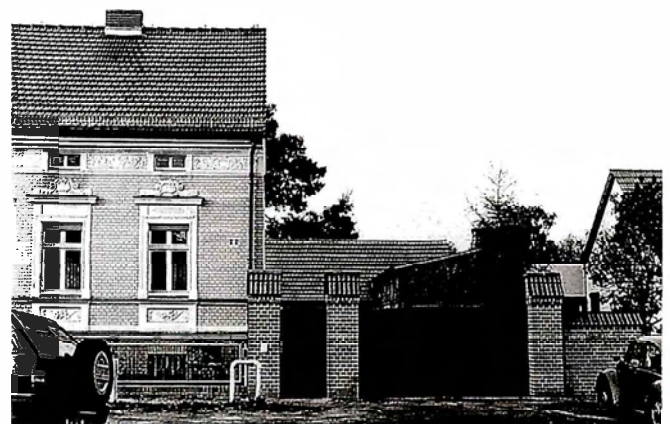
Pfeiler in Sichtmauerwerk mit Ziegeldeckung sowie Holztür als Hofeinfahrt
