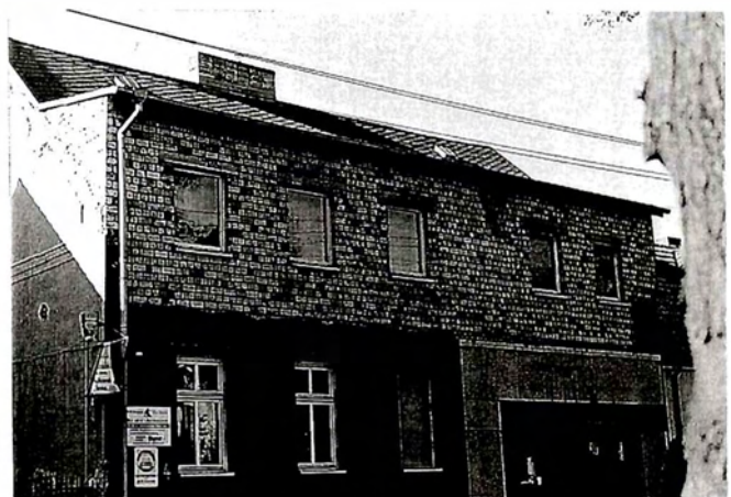
Die neue, durch Aufstockung entstandene Kubatur des Gebäudes führt zu einer Beeinträchtigung des Ortsbildes
