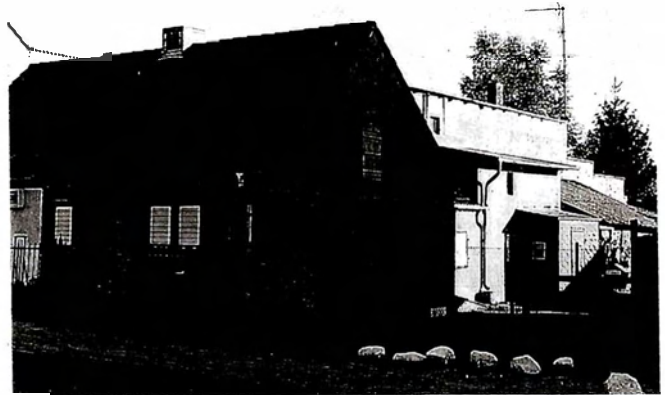
Aufstockungen landwirtschaftlicher Nebengebäude beeinträchtigen das Erscheinungsbild der Hauptgebäude
