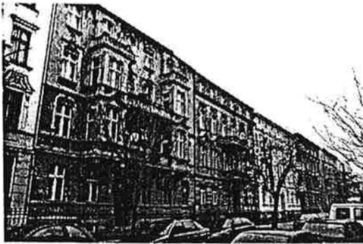
Geschlossene Bauweise, einheitliche Bauflucht, C.-v.-Ossietzkystraße
