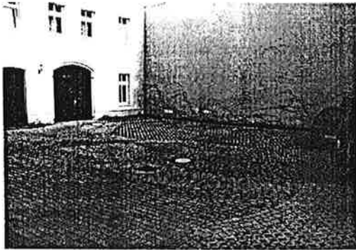
Negativbeispiel: vollversiegelte Hoffläche
