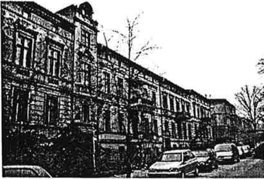
Gebäudeabfolge mit einheitlichen Trauf-, und Sockelhöhen, gleicher Geschossigkeit und durchlaufenden Gliedungselementen (z.B. Gesimse, Fensterreihung)
