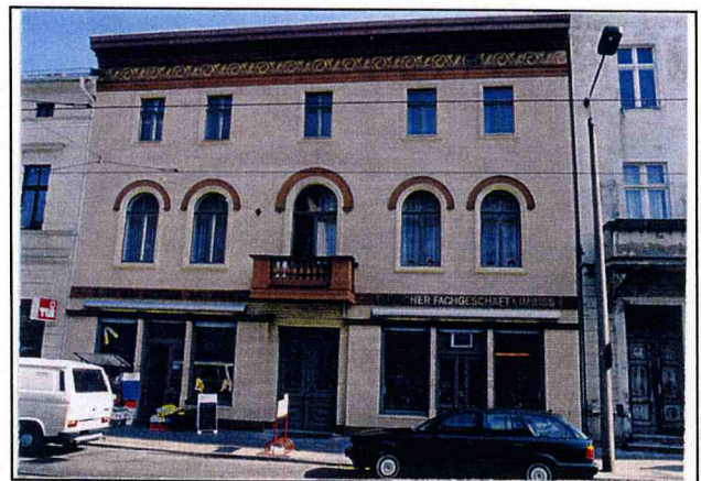
großflächige Öffnungen durch Schaufenster
