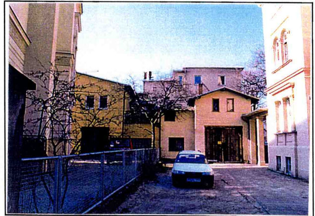
historische Remisen in der Hebbelstraße
