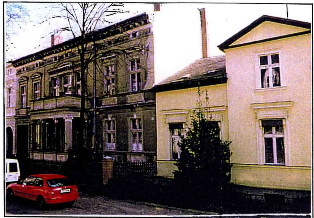
wechselnde Geschossigkeit in einem Straßenzug
