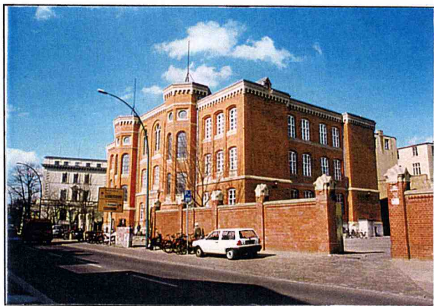
gebietsprägende Mauer an der Kurfürstenstraße
