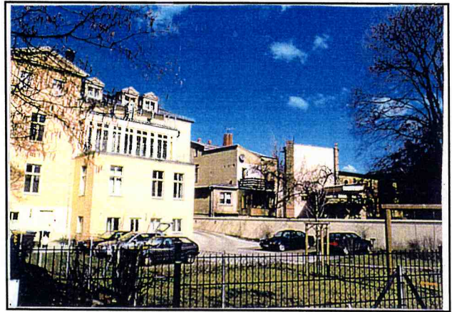
kleiner Anbau an der Gebäuderückseite
