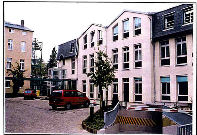
überdimensionierter Neubau eines „Nebengebäudes“
