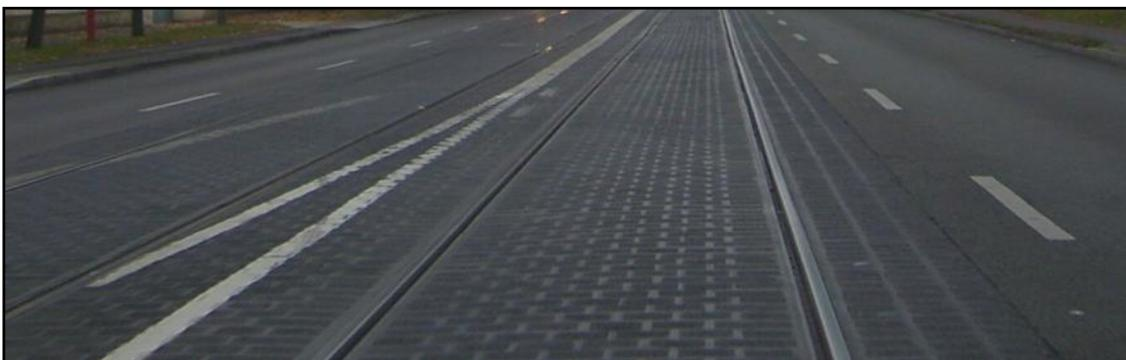
**Abb. 51** Gleiseindeckung mittels Pflaster
