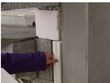
Dämmung des vorgesetzten Balkons
