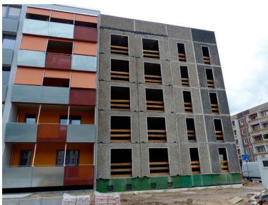
Fortführung der Gebäudesanierung im Pilotblock (Konrad-Wolf-Allee Ecke Eduard-von Winterstein-Straße)
