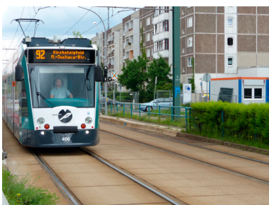
Straßenbahntrasse mit Betonplatten
