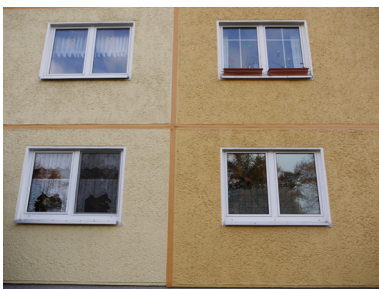
Fassade mit Fugensanierung
