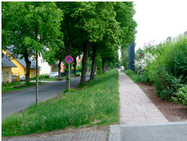
Aufschüttung des Untergrunds
