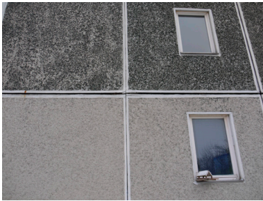
Fassade in Originalzustand
