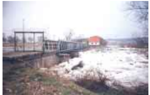
Bild 27: Eisversetzungen unterhalb des Wehres Widuchowa (Oder Jan. 2003)
