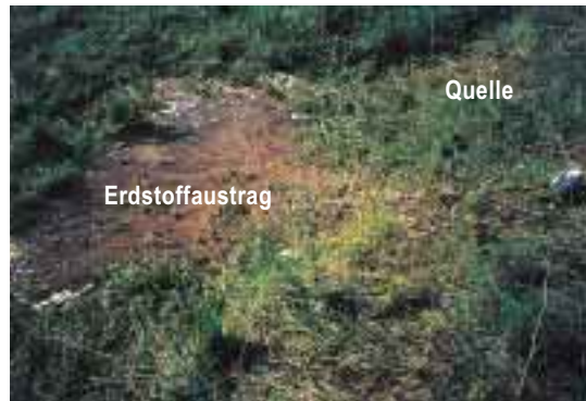
Bild 16: Sickerwasser mit Erdstoffaustrag Oder-Spree-Kanal km 0,8 (1997)
