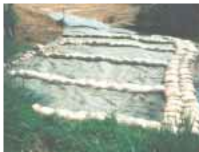
Bild 13: Elbe bei Mödlich (Baustellensicherung 02/1995-12/1995)
