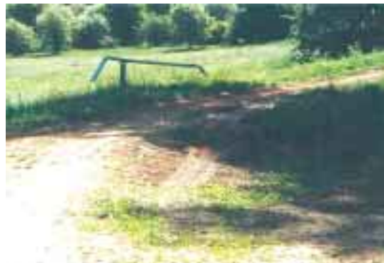
Bild 5: Zerstörte Grasnarbe (Haveldeich) durch Umfahren der Deichsperrung
