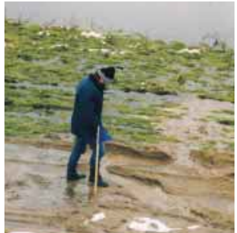
Bild 7: Kontrolle des Sickerwasserstandes an der luftseitigen Böschung des Elbdeiches (Januar 2003)
