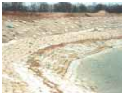
Bild 15: Flächendeckende Sandsackauflast (Baustellensicherung) wasserseitig Elbdeich 1994
