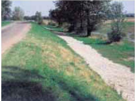
Bild 32: Auflastfilter bei aufgeweichten Böschungen aus Filterkies, Korngröße 4-32 mm, Oderdeich D-km 25,7 bis 29 1997
