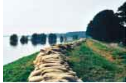
Bild 20: Aufkadung des Elbdeiches im Bereich der Ortslage Gnevsdorf (August 2002)
