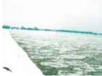
Bild 25: Elbdeich bei Jagel (Jan. 2003) Deichgefährdung durch in der Strömung rotierende Eisschollen, die sich kreissägeartig in die Böschungen einschneiden. Diese horizontalen Einschnitte erreichten innerhalb weniger Stunden die Größenordnung von 3m und die unterhöhlten Bereiche brachen wenig später senkrecht nach.
