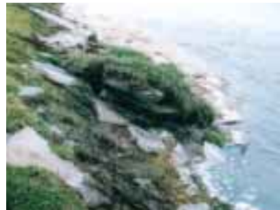
Bild 26: Elbdeich bei Wootz (Jan. 2003) Böschungsschälung durch Eis
