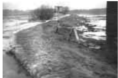
Bild 21: Aufkadung und Sickerstellenverbau am SW Witzke II (Gr. Havelländ. Hauptkanal 1982)
