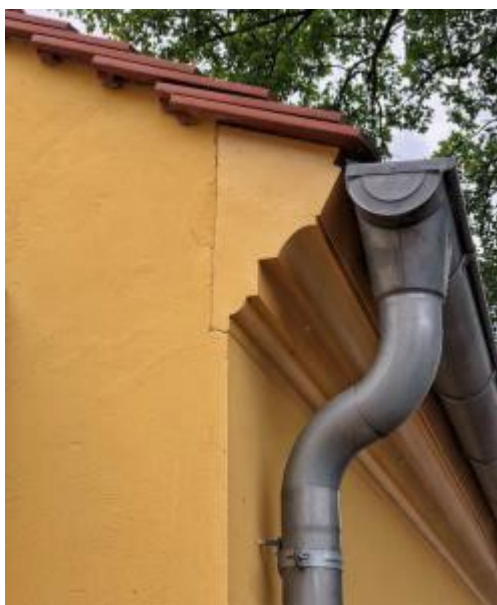
Typischer Traufbereich und Giebelanschluss bei einem Kolonistenhaus
