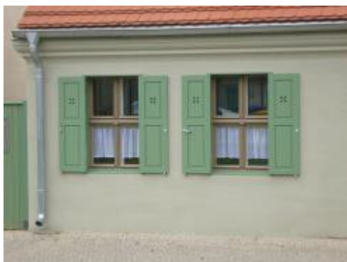
Klappläden mit Leibungskästen an einem Kolonistenhaus
