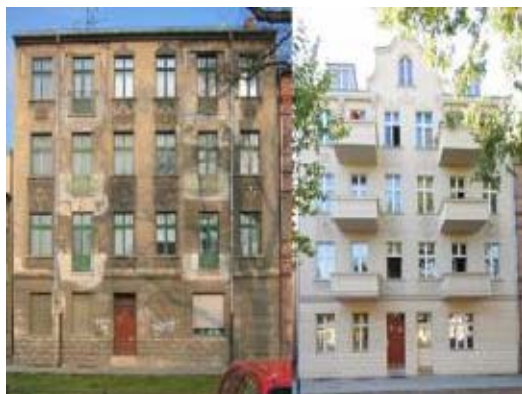
Vorher Rekonstruierte Fassadenelemente (Balkonanlagen und Frontspieß) Nachher
