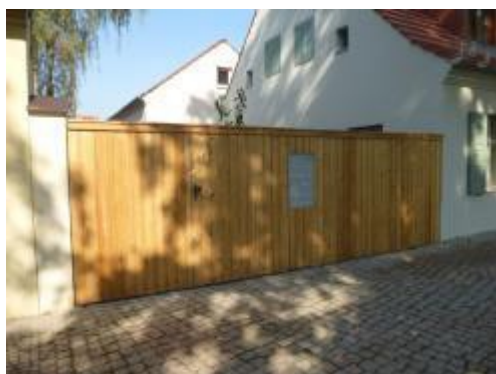
Briefkastenanlage in Holzzaun integriert
