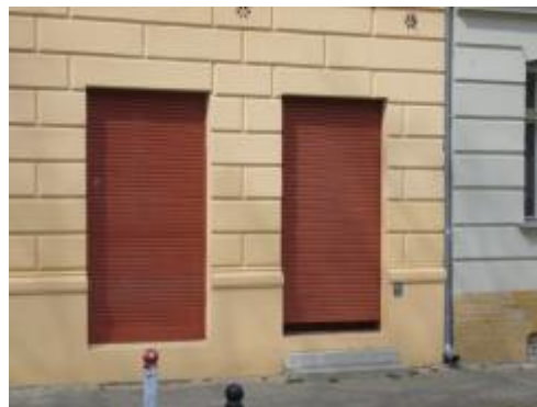
Beispiel für Rollläden an einem Gründerzeitgebäude
