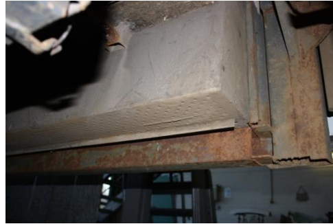
Türbereich, Einstieg unten
