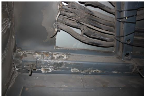
beschädigter Kabelschutz
