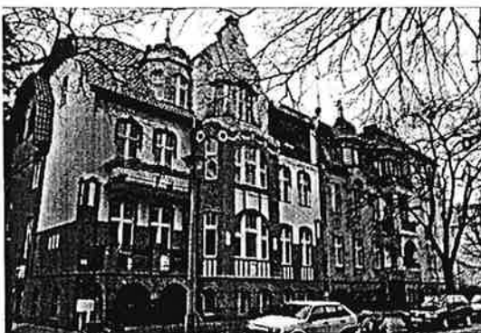
Offene Bauweise mit einheitlicher Bauflucht (nördl. Nansenstraße)
