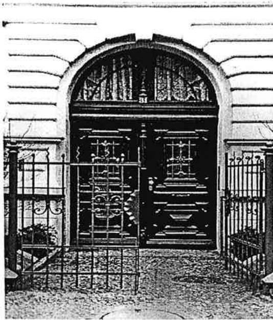
Hauszugang in Mosaikpflaster
