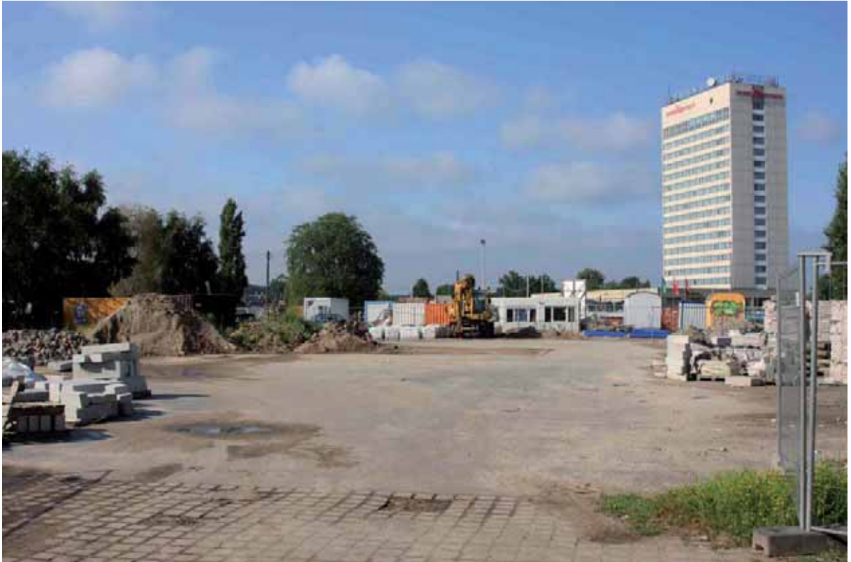
Abb. 4: Baustelle im Südwesten des B-Plangebietes
