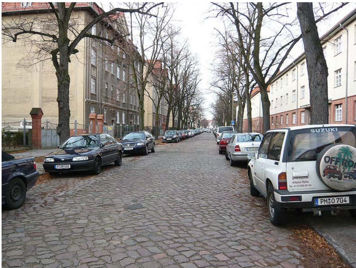
Kopernikusstraße – Schlechter Straßenzustand und fehlende Parkmöglichkeiten
