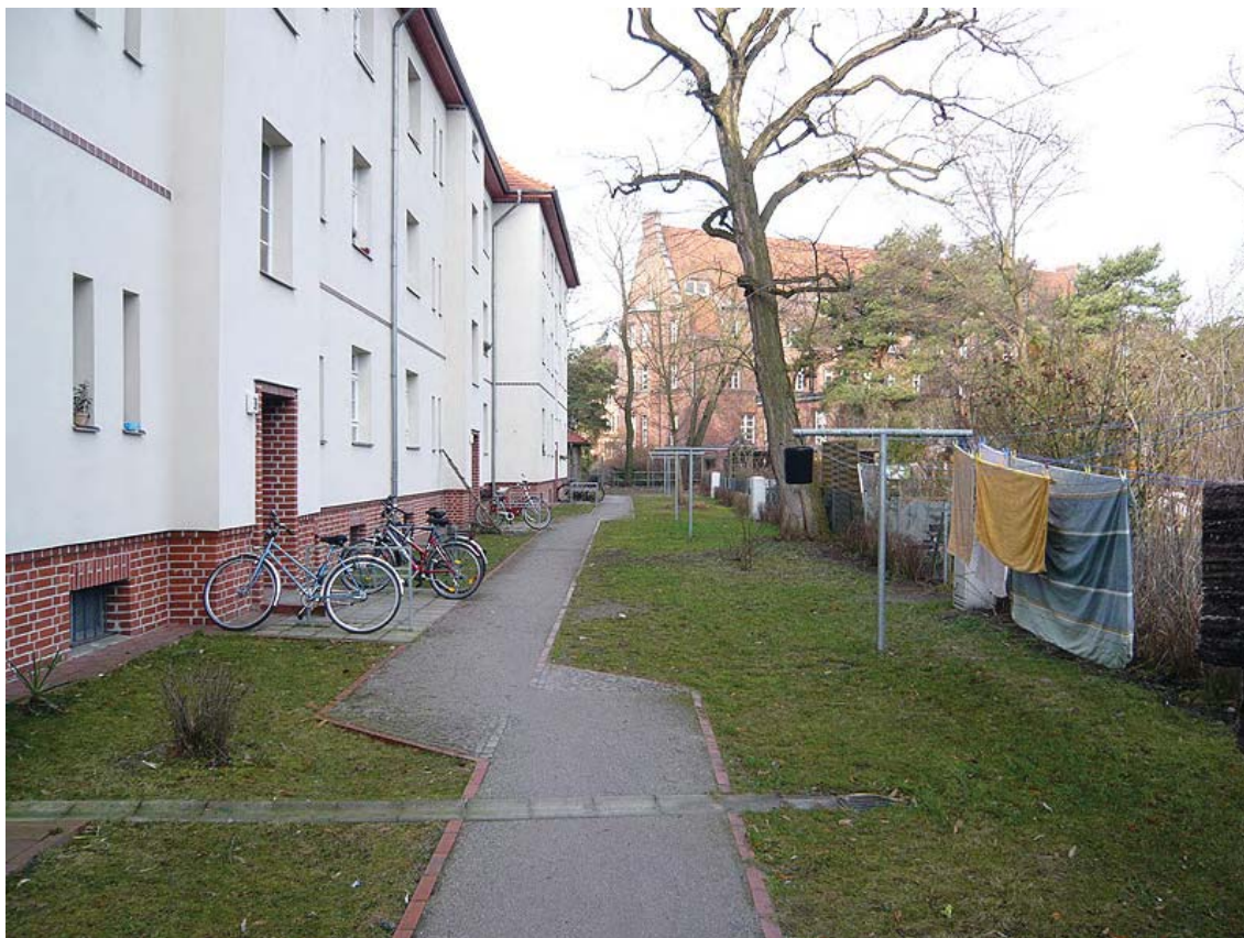
Kopernikusstraße 34 -54 – Rückfassade und Hof
