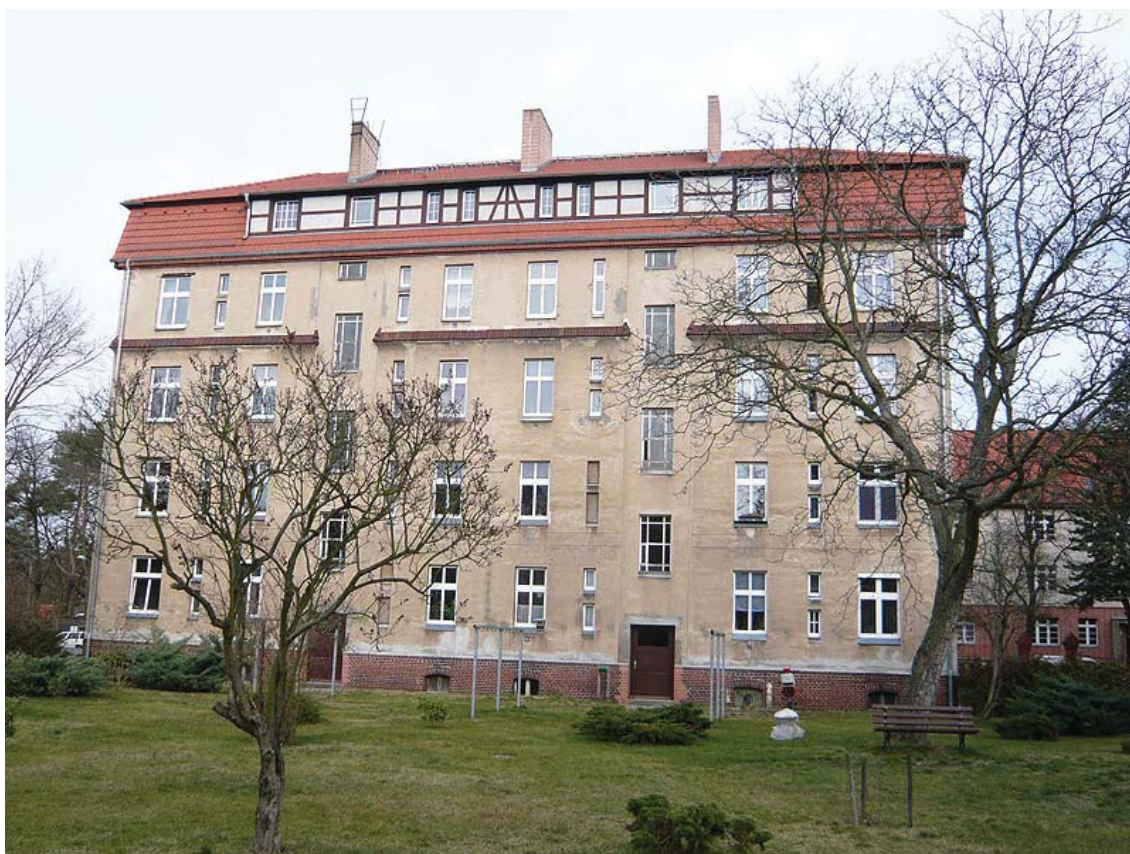
Innenhof und Rückfassade Kopernikusstraße 47-49
