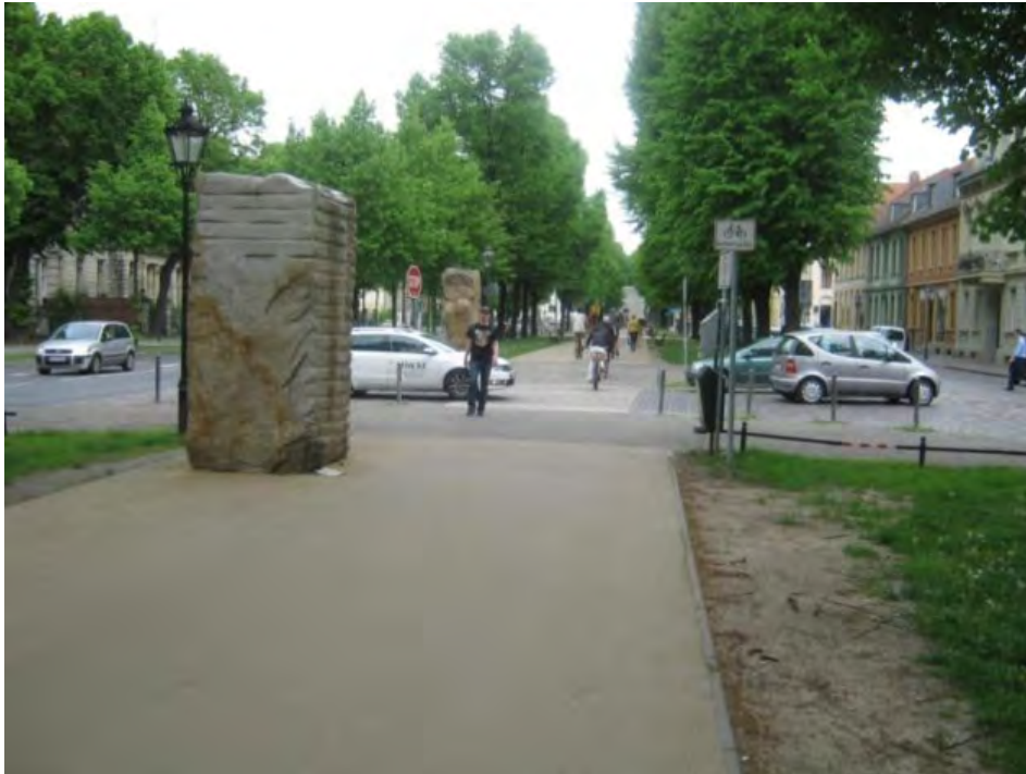
Abb. 35 Im Bereich Dortustraße wurde die Sicht zwischen den Verkehrsteilnehmern durch Steinquader eingeschränkt (Foto: PGV)
