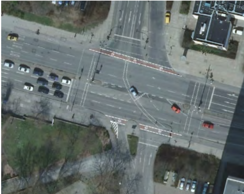
Abb. 55 Die rote Markierung der Radverkehrsfurten an der Breiten Straße über die Einmündungen Wall am Kiez und Schopenhauerstraße sollten erneuert werden. (Fotomontage: PGV, Grundlage Luftbild LHP 2009)
