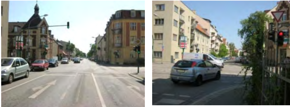
Abb. 88 Kreuzung Großbeerstraße / Horstweg / Fultonstraße nach der Neumarkierung (Juni 2012) Links: Vorgezogener Aufstellbereich für Radfahrer Rechts: Bei Rot in Großbeerstraße einbiegender Pkw (Grünpfeil) (Fotos: PGV)
