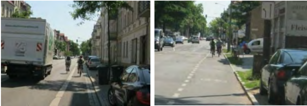
Abb. 100 Westlich der Walter-Klausch-Straße (links) wurde der Radverkehr im Juni 2012 auf Radfahrstreifen dicht neben den parkenden Kfz geführt, östlich davon (rechts) waren zu dem Zeitpunkt bereits die Schutzstreifen mit Sicherheitsabstand zu den parkenden Kfz markiert. (Fotos PGV)
