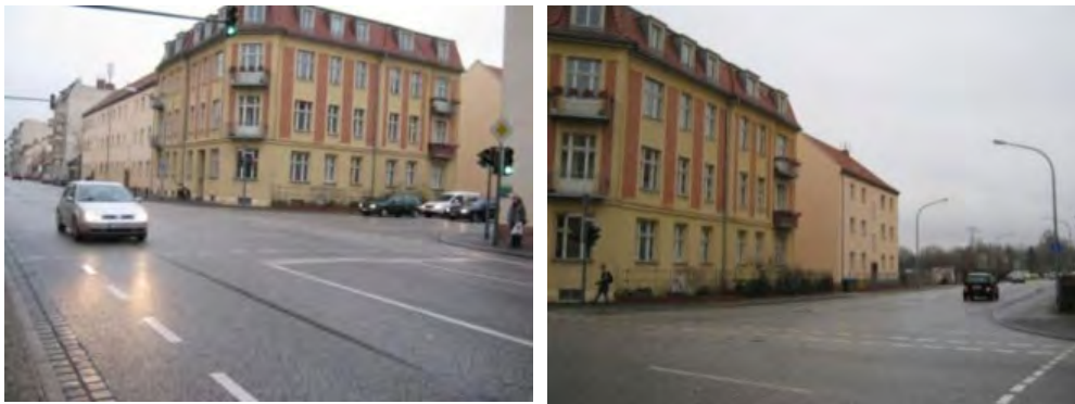
Abb. 87 Kreuzung Großbeerenstraße / Horstweg / Fultonstraße vor der Neumarkierung (Januar 2012) (Fotos: PGV)
