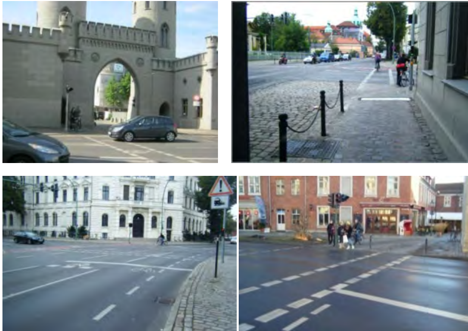
Abb. 26 Seit Dezember 2010 gibt es Radverkehrsfurten über die Hegelallee im Zuge der Torbögen des Nauener Tors. Die Führung parallel zu den Fußgängerfurten blieb dabei bestehen. (Fotos: PGM)
