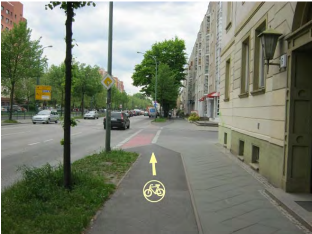
Abb. 45 Vorschlag: Markieren von Richtungspfeilen auf Radweg und Furt um das Gefahrenbewusstsein des Linksfahrens für Radfahrer zu erhöhen (Fotomontage PGV). Markierung der Pfeile bereits an der Kreuzung 106 in Richtung der Einmündung Lennéstraße.
