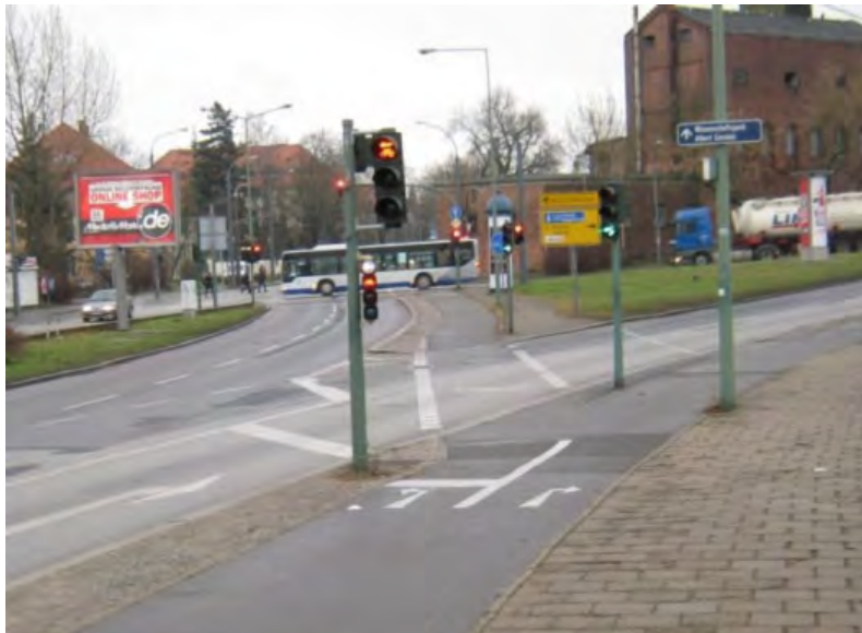
Abb. 73 Rechtsabbieger in den Brauhausberg heute: Signalisierung getrennt vom geradeausfahrenden Radverkehr (Foto: PGV)
