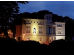
Villa Schöningen, Glienicker Brücke
