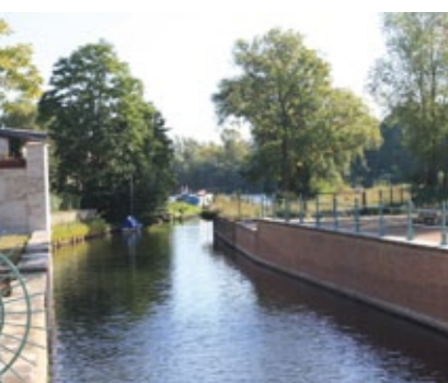
Deuxième tronçon du canal de la ville rue Heilig-Geist (75)
