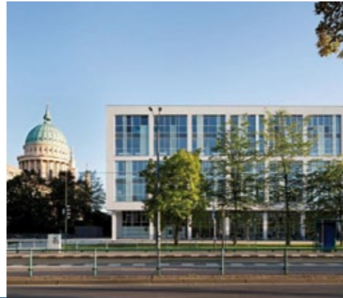
Potsdam's 'Bildungsforum' at the square 'Platz der Einheit' with a view of church 'St. Nikolaikirche' (31)
