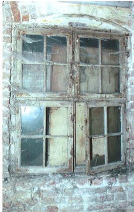
Originales Fenster Benzstraße 31.
