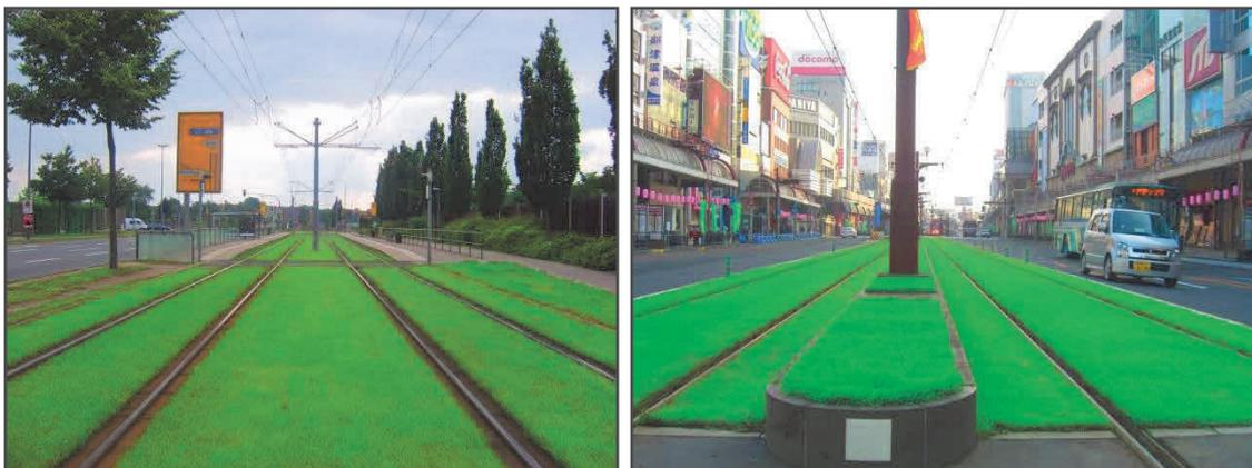
**Abb. 40** Beispiele für hochliegendes Rasengleis Dresden, Japan
