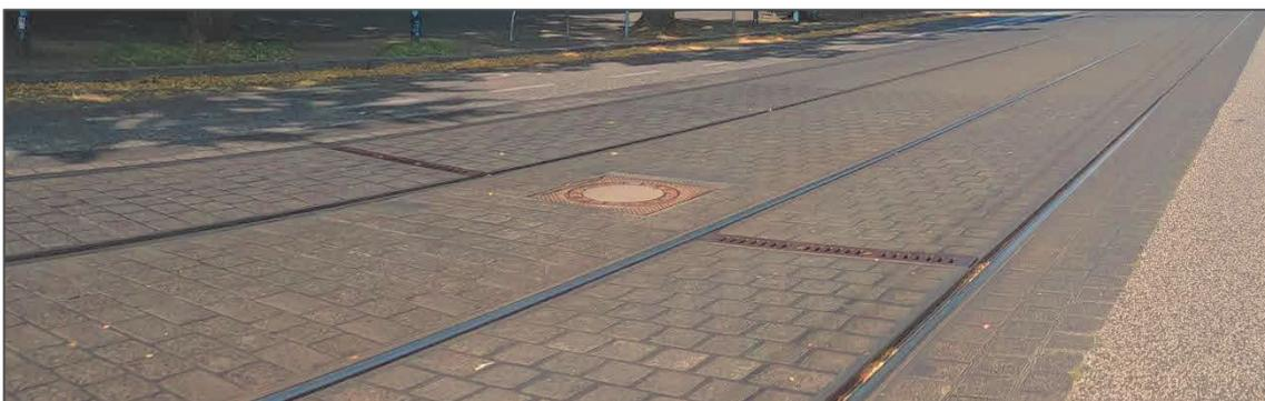
Abb. 42 Gleiseindeckung mittels Pflaster
