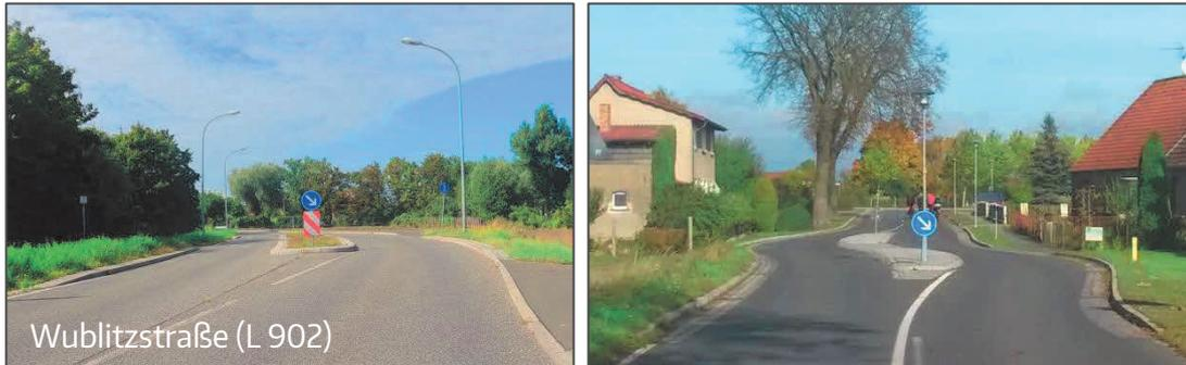
**Abb. 35** Beispiele Ortseingangsgestaltung mit Fahrstreifenversatz
