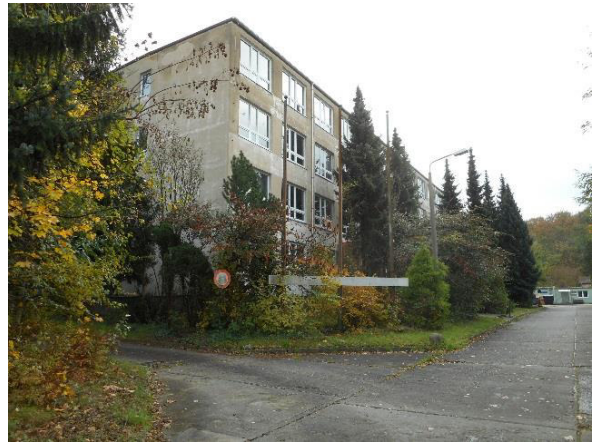
Abbildung 4: Bürogebäude auf Plangebiet
