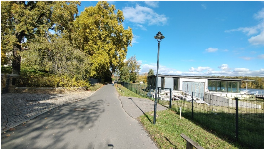
Abb. 48 Bertinistraße und Bootshausbaustelle, links der Garten der Villa Starck. Foto GDB Oktober 2022.
