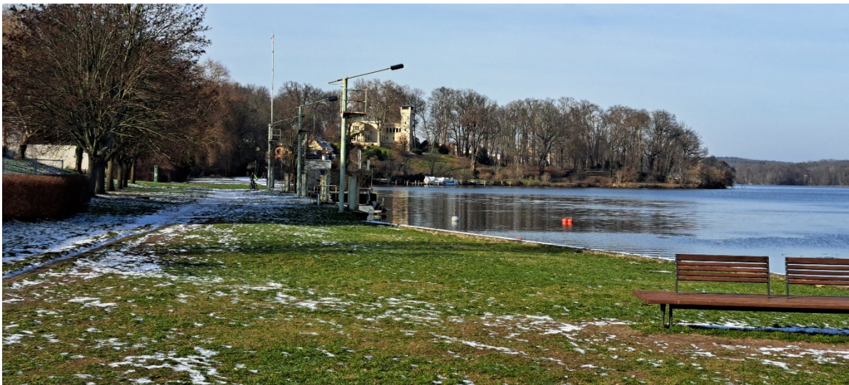
Abb. 12 Bertiniufer, Anlagen der GÜSt Nedlitz, nördlicher Abschnitt. Die Landerweiterung beträgt ca. 15 Meter. Foto GDB Februar 2023.
