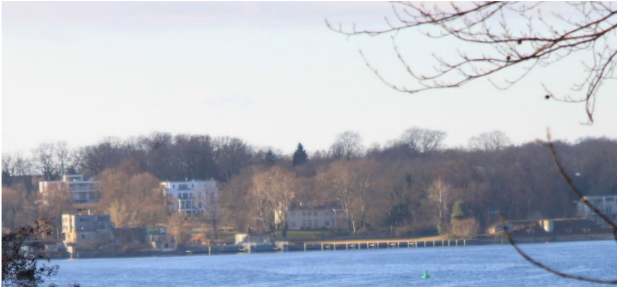
Abb. 35 Stark vergrößerter Ausschnitt von Abb. 35. Fotostandort Glienicker Ufer. Die Villa Starck im Zentrum, an der Wasserlinie die Spundwand und das Bootshaus, dessen Dachlinie deutlich unterhalb der Fußlinie der Villa liegt. Foto GDB Dezember 2021.
