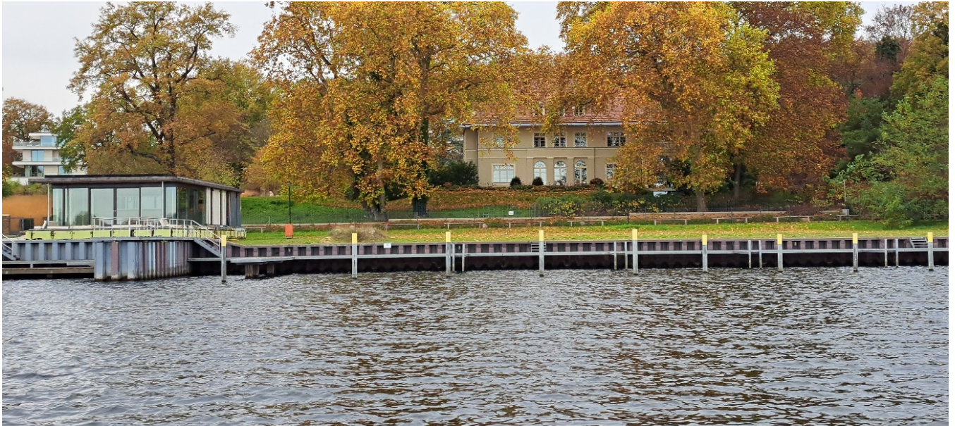
Abb. 56 Blick vom Motorboot auf das Bertiniufer. Die Spundwand und das Bootshaus wirken aus der geringen Blickhöhe und dem geringen Blickabstand recht gewichtig. Die weit vom Ufer zurückgesetzte Villa Starck bleibt dennoch dominant. Foto GDB November 2022.
