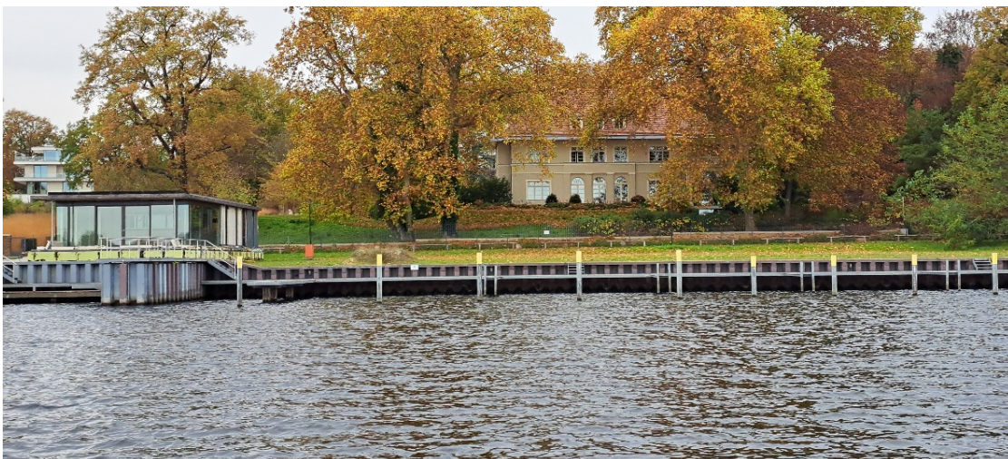
Abb. 45 Die Spundwand der GÜSt, mit neu gesetzten Dalben und dem Bootshaus in der Achse des ehem. Portalkrans. Die Spur der Grenzanlage ist denkmalpflegerisch vorbildlich und zugleich funktional sinnvoll in die neue Freizeitlandschaft integriert worden. Foto GDB November 2022.
