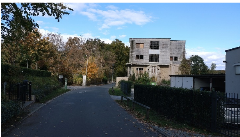
Abb. 47 Die Villa Hagen, Blick von Süden. Foto GDB Oktober 2022.
