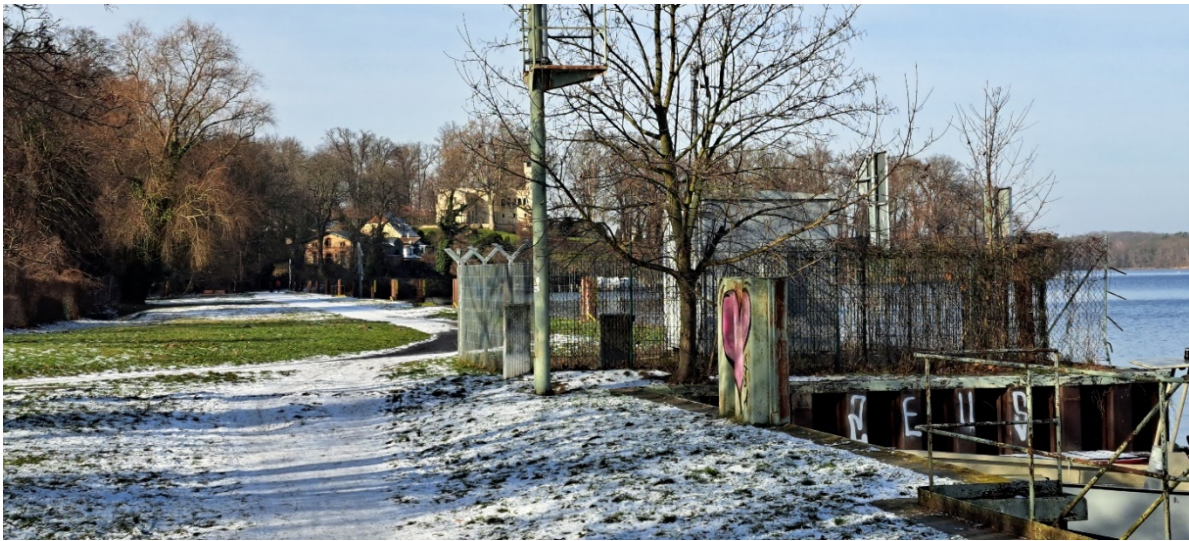
Abb. 11 Bertiniufer, Anlagen der GÜSt Nedlitz, nördlicher Abschnitt. Die Landerweiterung beträgt ca. 15 Meter. Foto GDB Februar 2023.
