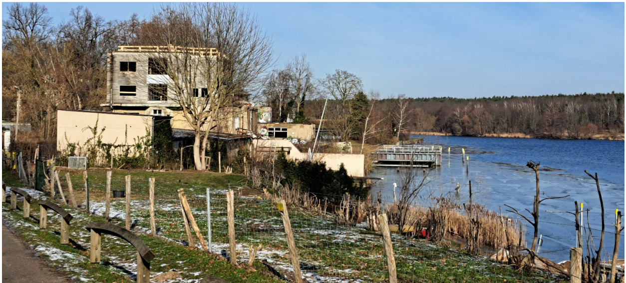
Abb. 46 Bertiniufer, Villa Hagen, Blick von Süden. Rechts, im Wasser, die für das Bootshaus nachgenutzten Stützen des ehemaligen Portalkrans. Foto GDB Februar 2023.
