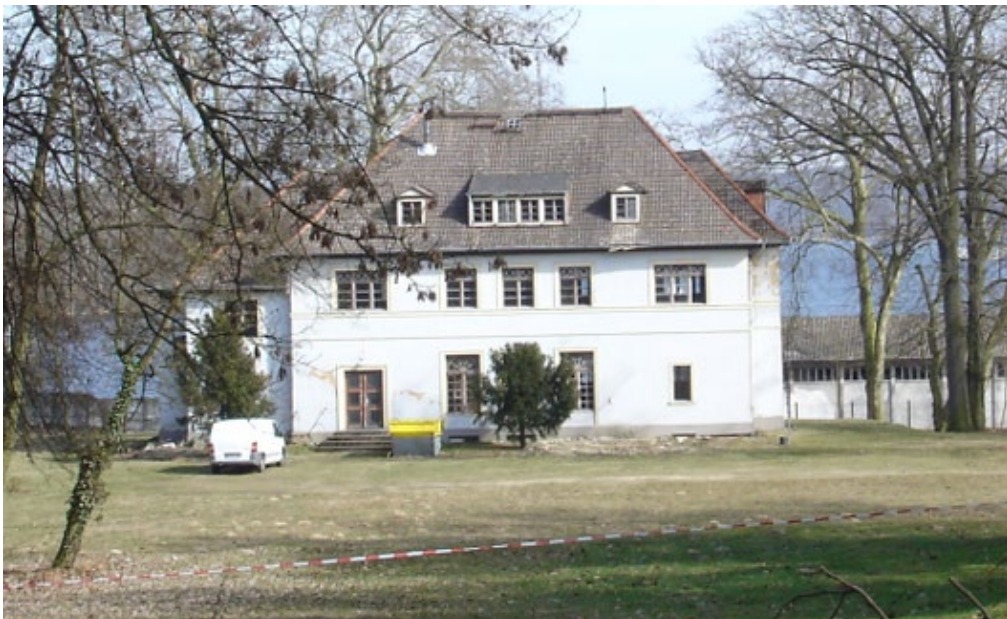
Abb. 5 Villa Starck 2005 vor Beginn der Umbauten und Renovierungen. Rechts im Bild die große Bootshalle der NVA. Foto: privat.
