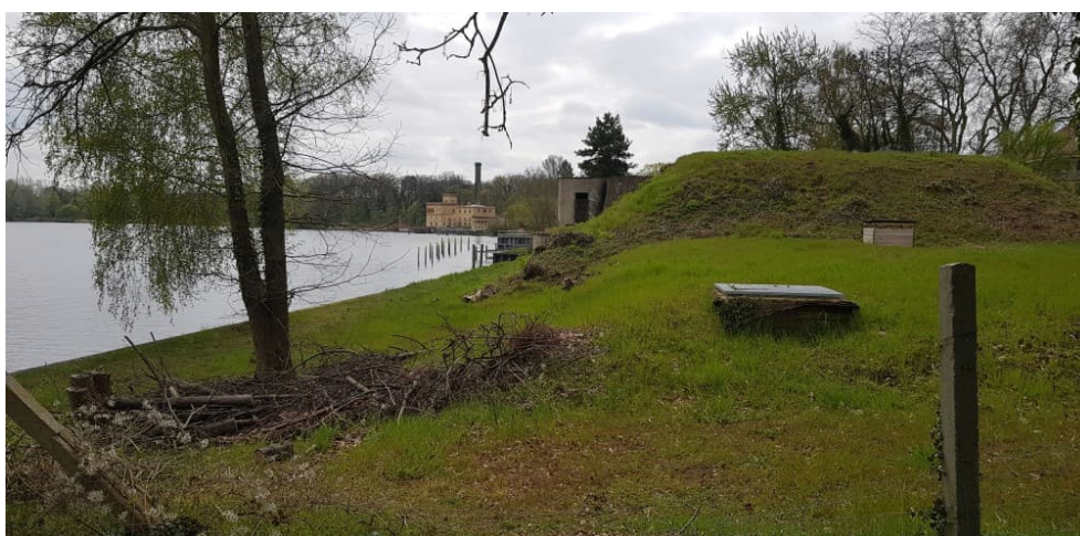
Abb. 11: Gewölbe des ehem. Wasser- werks, Grünflächen
