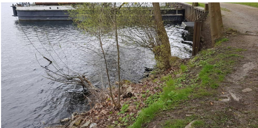
Abb. 4: Spundwand und Steinschüttung als Uferbefestigung
