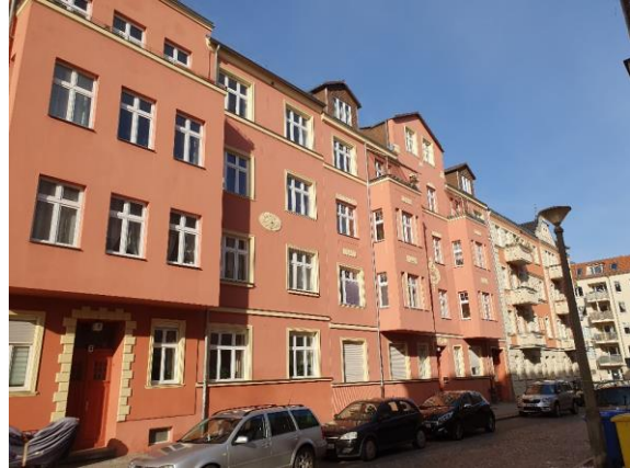
Abbildung 9: Altbau Teltower Vorstadt Nord
