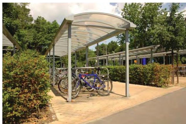
Abbildung 11: Fahrradparker am Bahnhof Potsdam-Rehbrücke
